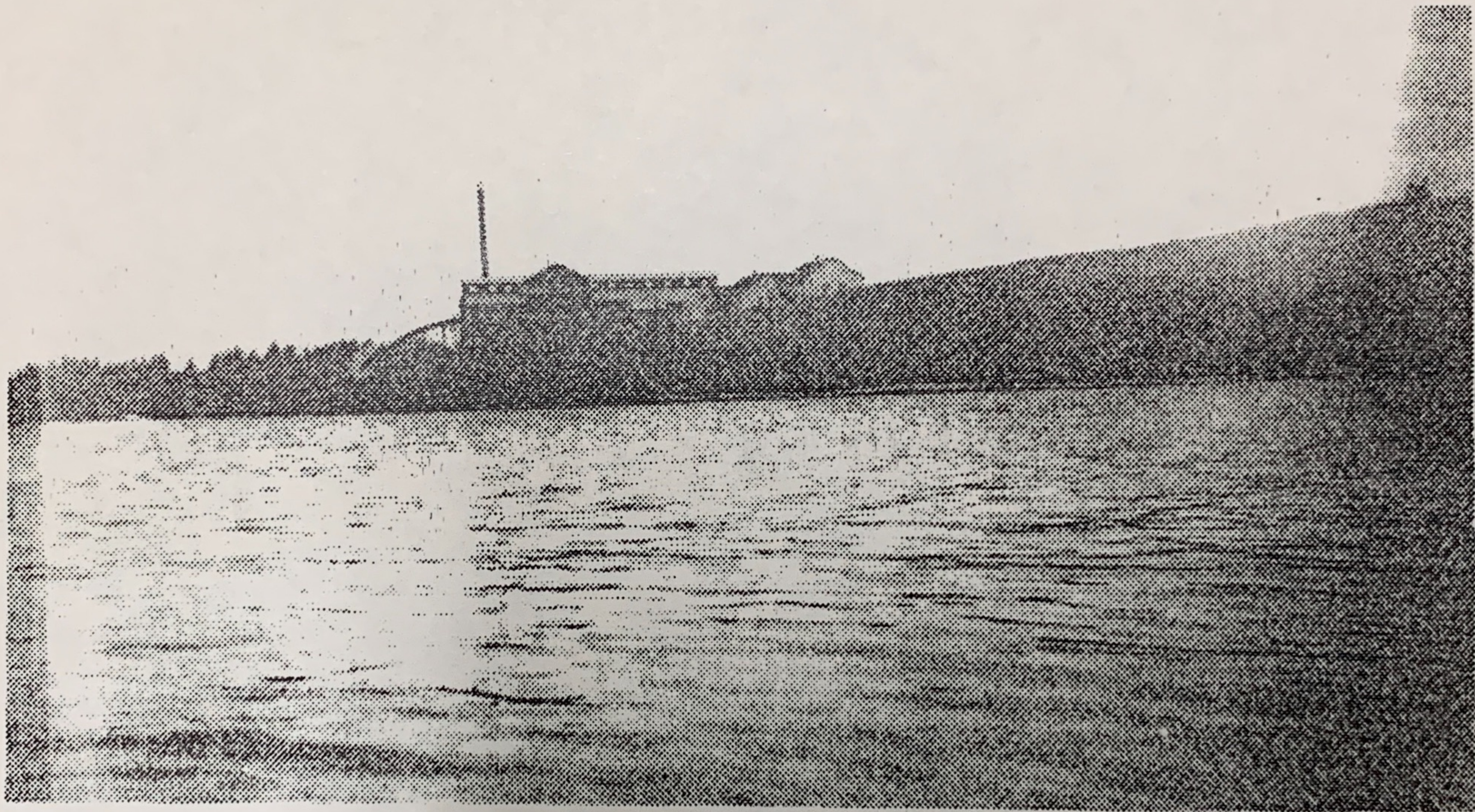
Le moulin, côté ouest de la rivière
